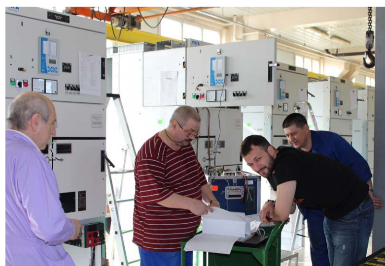
Проведение наладки оборудования
